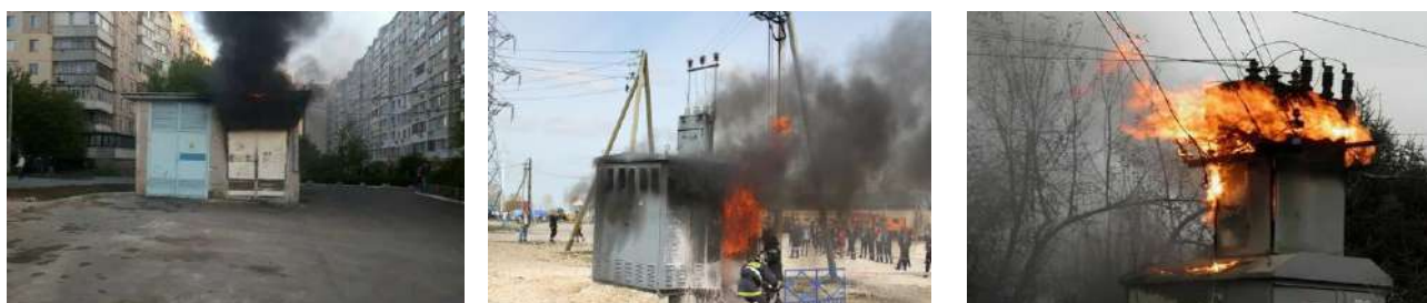
Рисунок 4 – Пожар на КТП: возгорание масляных трансформаторов
