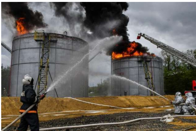
Рисунок 3 – Авария в резервуарном парке по хранению нефти с открытым пламенем
