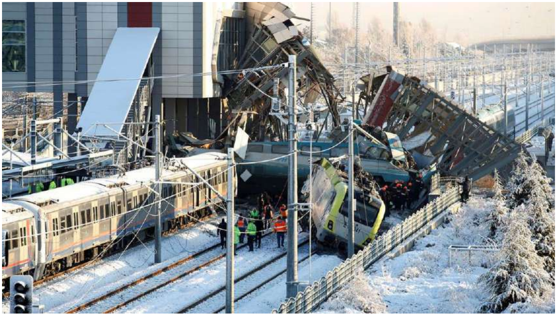
Рисунок 2 – Авария железнодорожного транспорта
