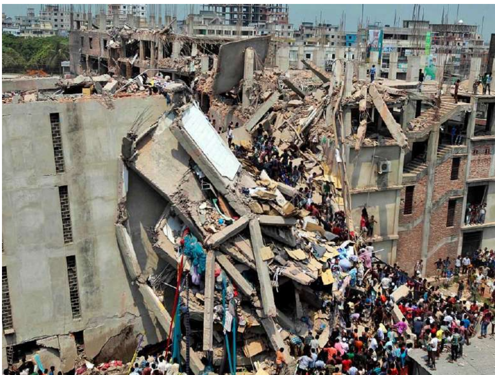
Рисунок 2 – Обрушение жилого здания
