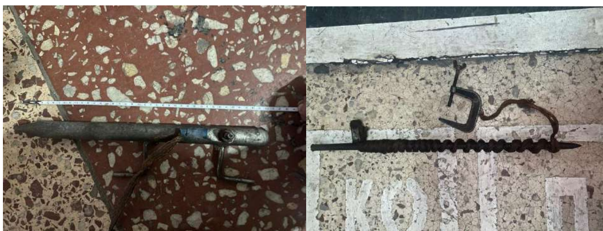
Рис. 1 – Внешний вид заземляющего штыря и самодельное заземляющее устройство
