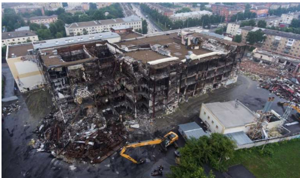
Рисунок 1 – Последствия пожара в ТЦ "Зимняя Вишня"
