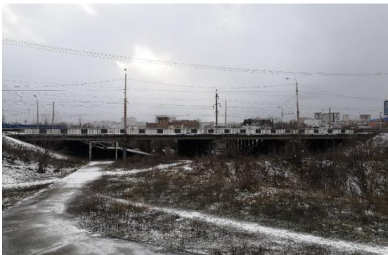
Рисунок – Общий вид моста через реку Темерник
